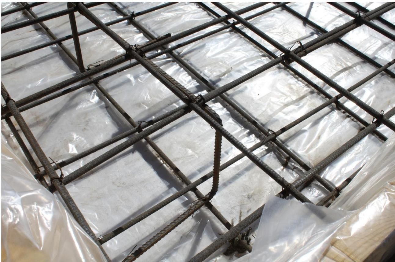
Рисунок 8 – Армирование и бетонирование комбинированного фундамента
