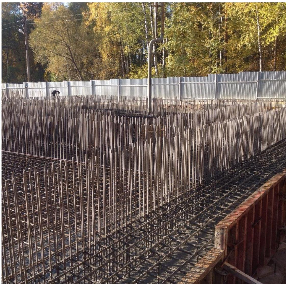
Рисунок 5 – Опалубка и армирование ленточного фундамента АКП «СТРОИТЕЛЬНЫЕ ИННОВАЦИИ»
