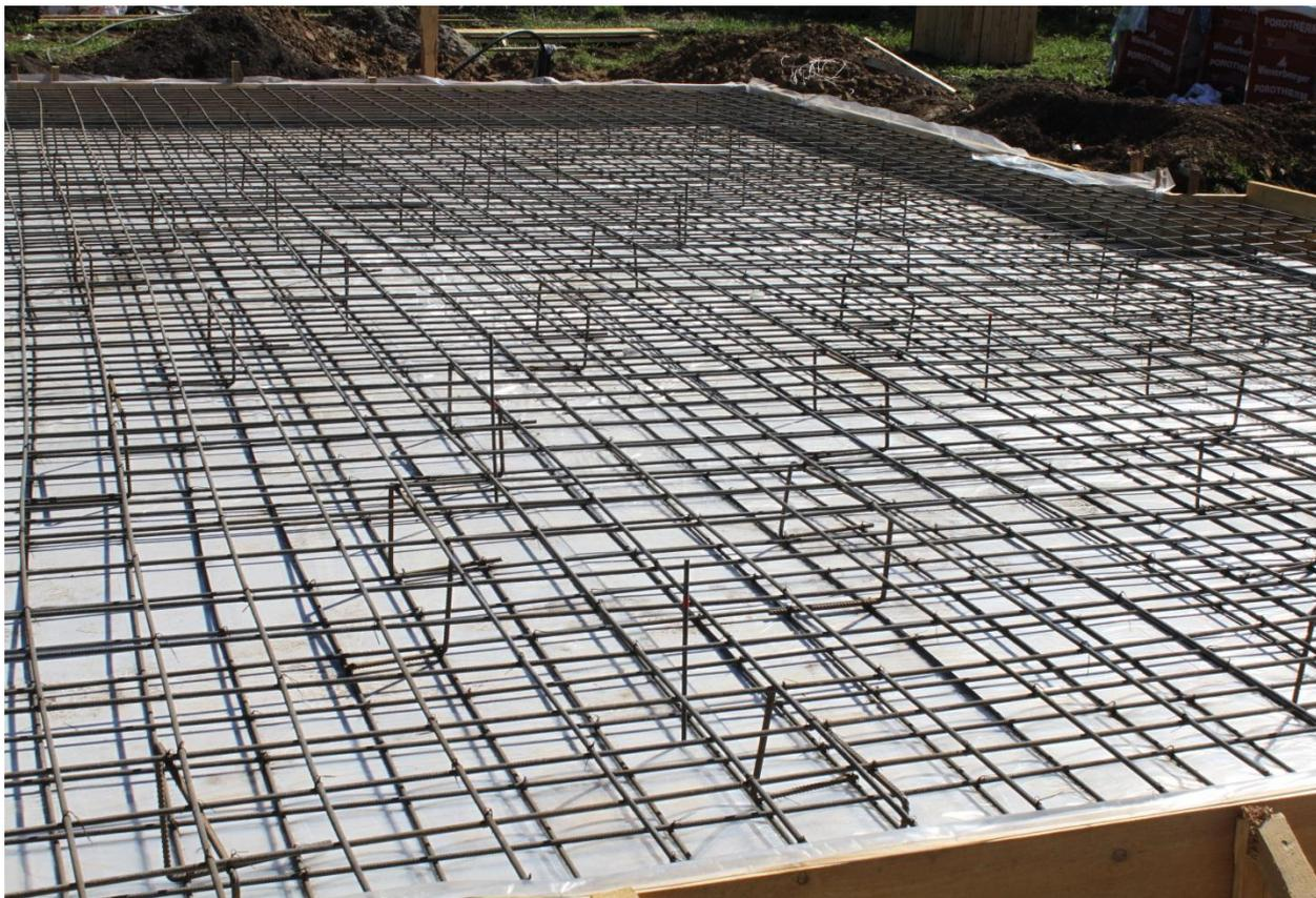
Рисунок 3 – Армирование плитного фундамента
